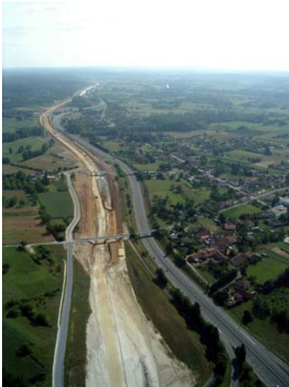
L'A 89 en construction, (Vidicom)
